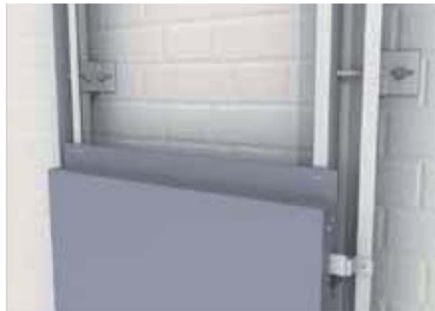
4. Mise en place des cassettes
