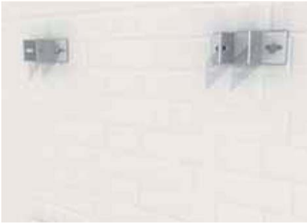
1. Pose des étriers
