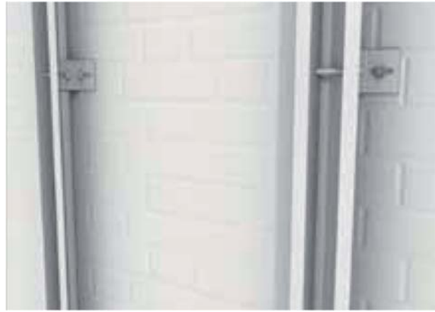
2. Installation des profils \Omega
